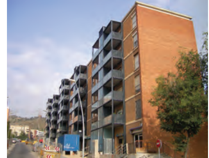
Rehabilitación de viviendas, Trinitat Nova, Barcelona. Fuente: Adigsa, empresa pública
