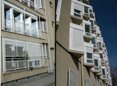
Rehabilitación de viviendas. San Cristóbal, Madrid. Fuente: M. de Luxán, G. Gómez.
