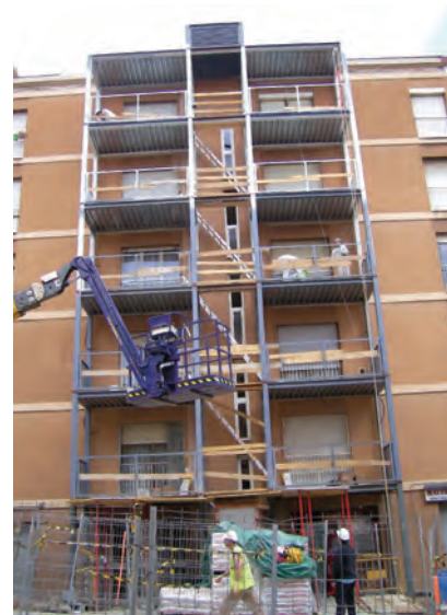
Rehabilitación de edificios en Trinitat Nova, Barcelona. Adigsa
