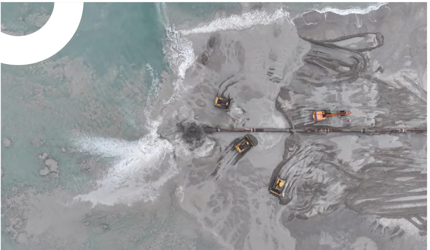
La tubería conectada a la draga aportando material y maquinaria pesada ampliando la playa.
